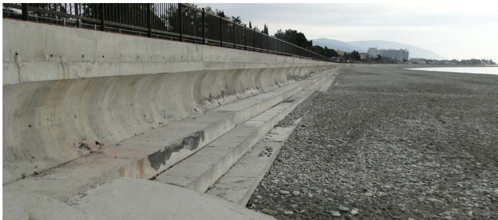
Рис. 6. Откосно-ступенчатая волноотбойная стена, возведённая перед набережной в Имеретинской бухте.
