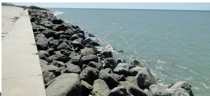
Рис. 7. Волногасящая берма из камня возведённая: а) над берегозащитной конструкцией; б) перед упорным поясом.
