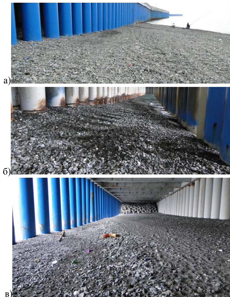
Рис. 2. Аккумуляция галечного материала под юго-западным оградительным молотом порта: а) перед молотом, июль 2015 г.; б) в волновой камере под молотом, апрель 2014 г.; в) июль 2015.
