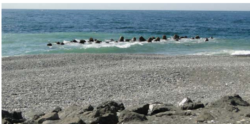
Рис. 9. Подводный волнолом, возведённый на восточном фланге Константиновского мыса.
