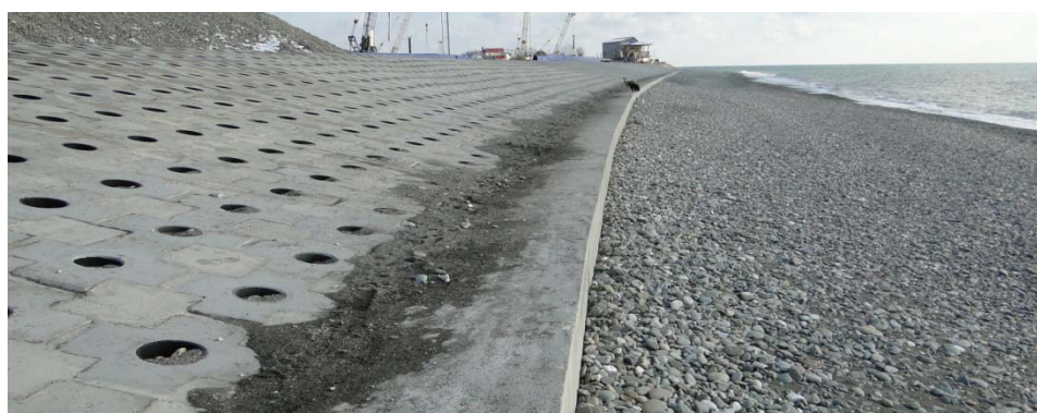
Рис. 4. Откосное берегозащитное сооружение с упорным поясом.
