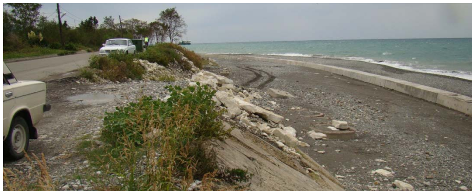
Рис. 5. Упорный пояс берегозащитной конструкции, выдвинутый в сторону моря к середине ранее существовавшего галечного пляжа.
